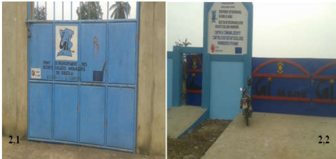
Planche 2: Sites des décharges contrôlées à Athiémé-centre et Atchannou Prise de vues: Dosseh, Janvier 2017
